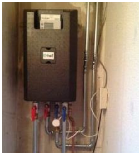
(de afleverset zorgt voor verwarming en warm tapwater)
